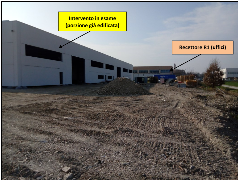
Figura 3: rilievi fotografici (vista lotto oggetto di intervento, lato sud)
